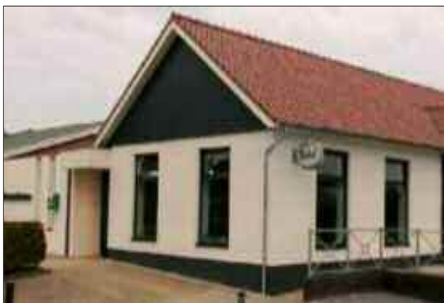
't Dorpshuus, Kruisdijk / corner Thijsweg 19 IJzerlo
